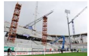
Foto von der Baustelle
