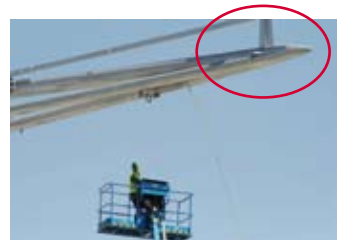
Montage des Gussknotens
